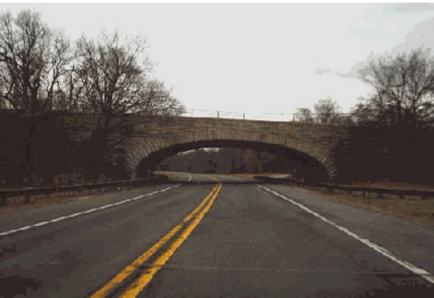
Brücke über Bethpage State Parkway
