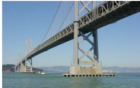
Bay Bridge (west) 2820m Länge 700m Spannweite
