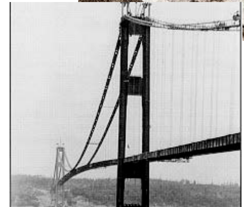
Tacoma Narrows B. 1520m Länge 850m Spannweite
