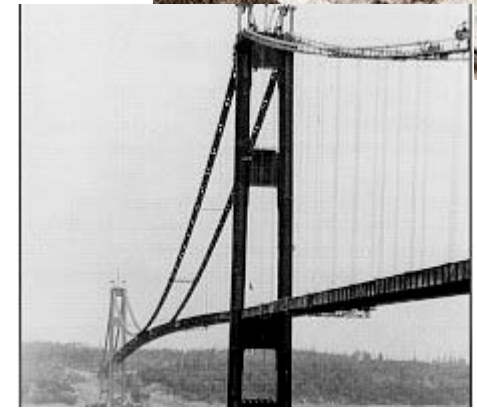
Tacoma Narrows B. 1520m Länge 850m Spannweite
