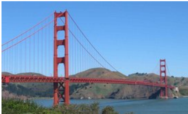
Golden Gate Bridge 1970m Länge 1280m Spannweite
