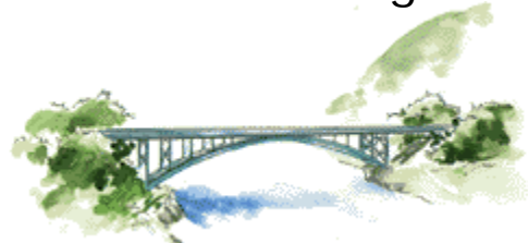
Bogenbr. (bis ~150m) Arch bridge
