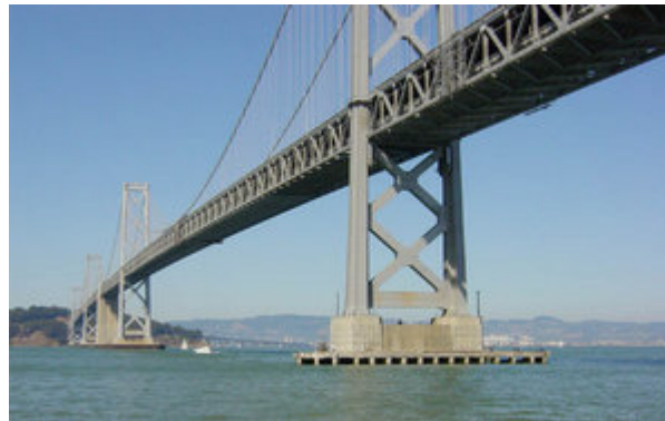
Bay Bridge (west) 2820m Länge 700m Spannweite
