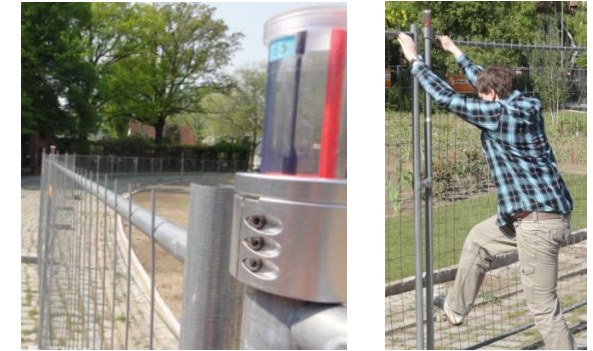
In den Zaun integrierte Sensorknoten erkennen Einbrüche
